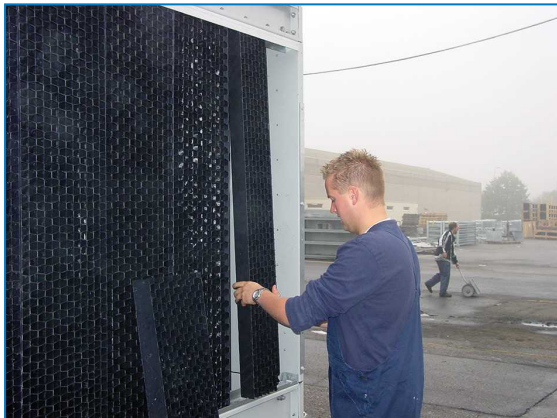
Démontage des déflecteurs d'entrée d'air
