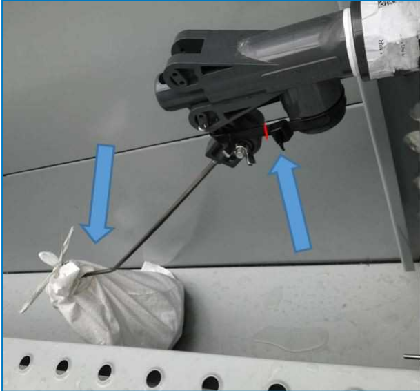
Fixation et emballage du flotteur sphérique
